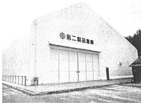
中瀬製錬所の第二製品倉庫
